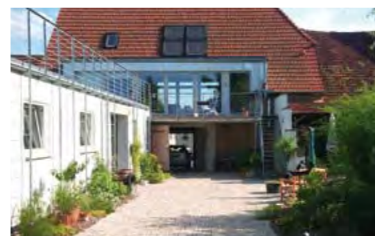
Das neu entstandene Passivhaus hat jetzt eine Solaranlage und eine Soleanlage zur Erdwärmennutzung.
